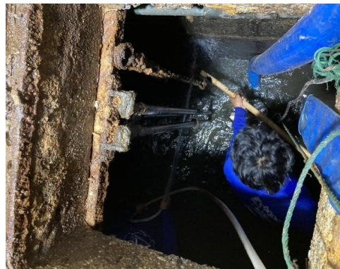
รูปที่ 2-7 สุ่มตะกอนส่วนเกินจากระบบบำบัดน้ำเสียไปกำจัด
