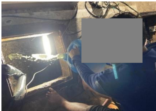
รูปที่ 2-7 สุ่มตะกอนส่วนเกินจากระบบบำบัดน้ำเสียไปกำจัด
