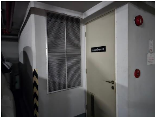
รูปที่ 2-36 ระบบระบายอากาศชั้นจอดรถใต้ดิน
