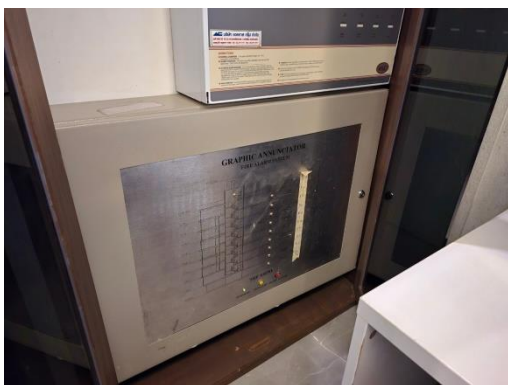
รูปที่ 2-21 ระบบป้องกันและเตือนอัคคีภัย
